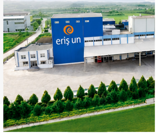
Silivri Eriş Un Fabrikası
